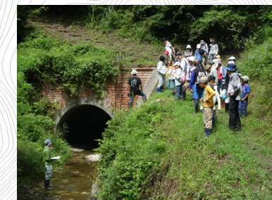
廃線敷の下の横断水路トンネル (レンガの積み方は特徴的)
