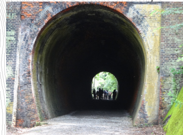
漆久保トンネル
